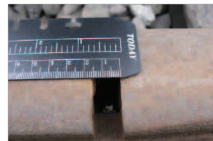
/ 轨检车通过铁轨缝隙会产生震动，对于整体系统会产生冲击，为此 Getac 将硬盘更换为固态硬盘。 /
